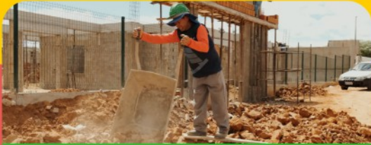
CONSTRUÇÃO DA CRECHE NA VILA SANTA MARIA
