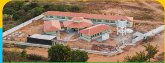
CONSTRUÇÃO DA ESCOLA NUCLEADA NA FEIRA NOVA
