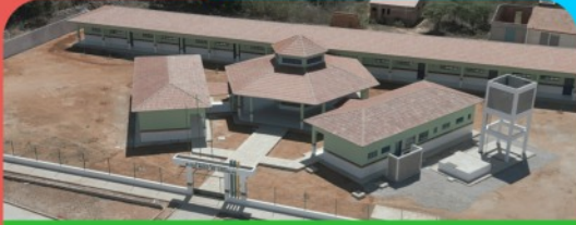
CONSTRUÇÃO DA ESCOLA NUCLEADA DA RANCHARIA
