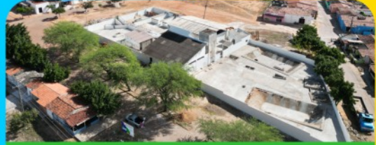
REFORMA DO MATADOURO PÚBLICO
