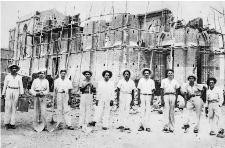
Trabalhadores voluntários na construção da Paróquia de Nossa Senhora da Conceição
